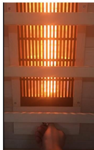
Manuální ovládání topných panelů pomocí potenciometrů
