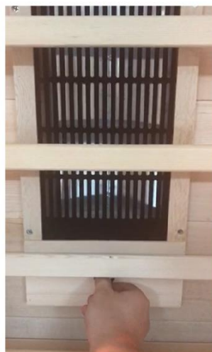
Manuální ovládání topných panelů pomocí potenciometrů
